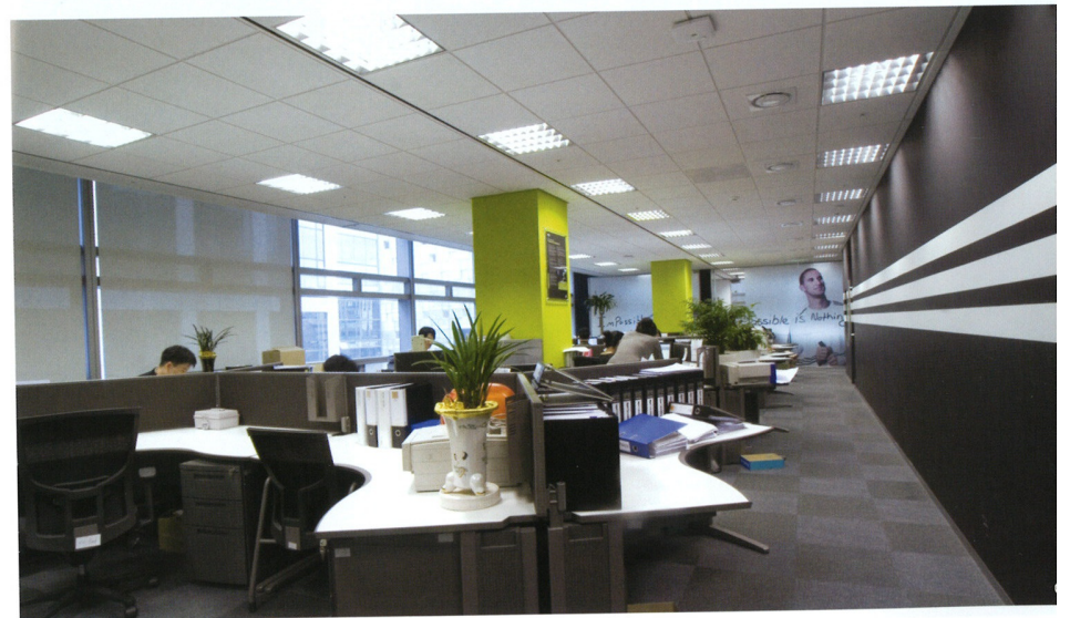
05. 8층 사무공간의 전경. 중앙에 위치한 회의실 벽면의 로고가 역동적인 분위기를 연출한다. 06. 8층 사무공간의 디테일. 천정에 직사각형으로 구멍을 뚫고 그 안에 형광등을 매입한 뒤 격자로 된 루버로 마감했다.
